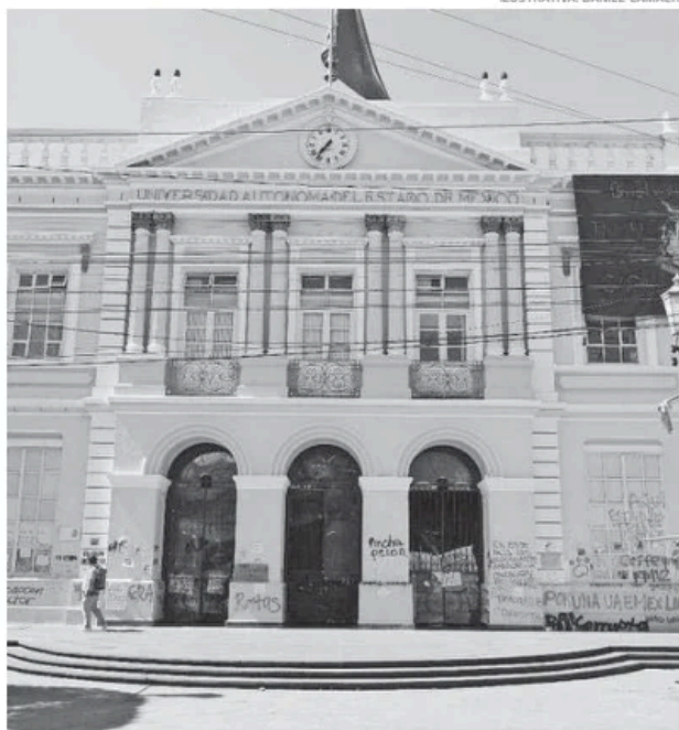
El edificio de Rectoría recibió una inspección por parte del INAH
