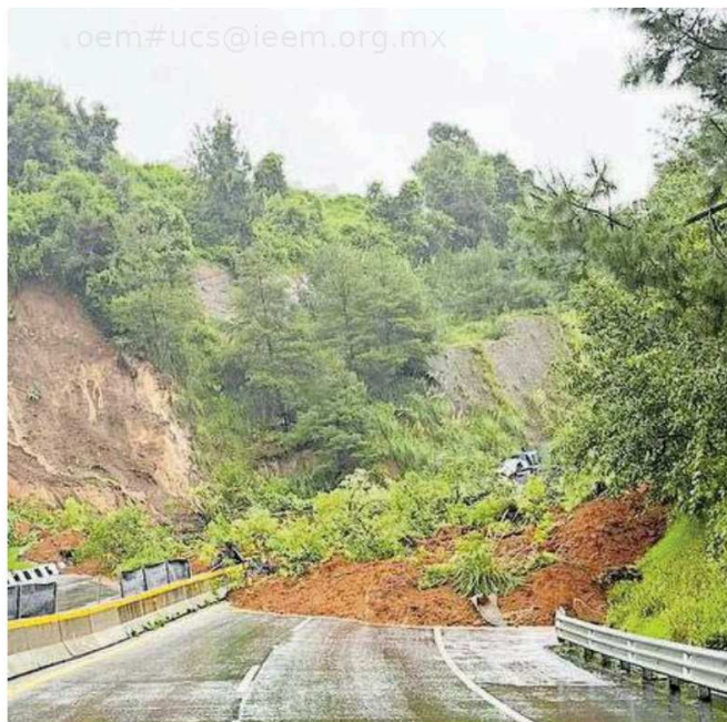
La mañana del viernes, se registró un deslizamiento de tierra en la autopista Tenango-Ixtapan que cubrió completamente los carriles en ambos sentidos
