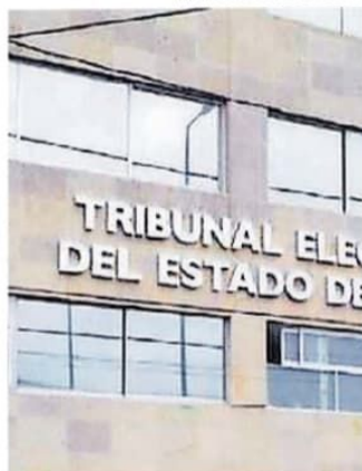
Se emitieron requisitos excesivos.
