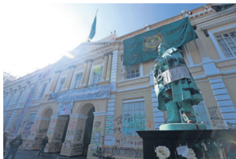
Se informa que las afectaciones derivan, principalmente, de la acumulación de humedad ocasionada por las lluvias recientes.
