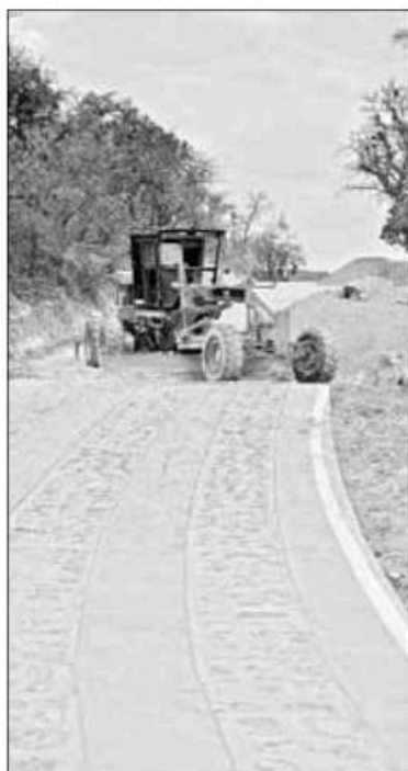
▲ El presidente Andrés Manuel López Obrador supervisó ayer obras en San Pedro Coxcattepec Cántaros, Oaxaca, como parte del Programa Nacional de Caminos de Mano de Obra. Foto Presidencia
