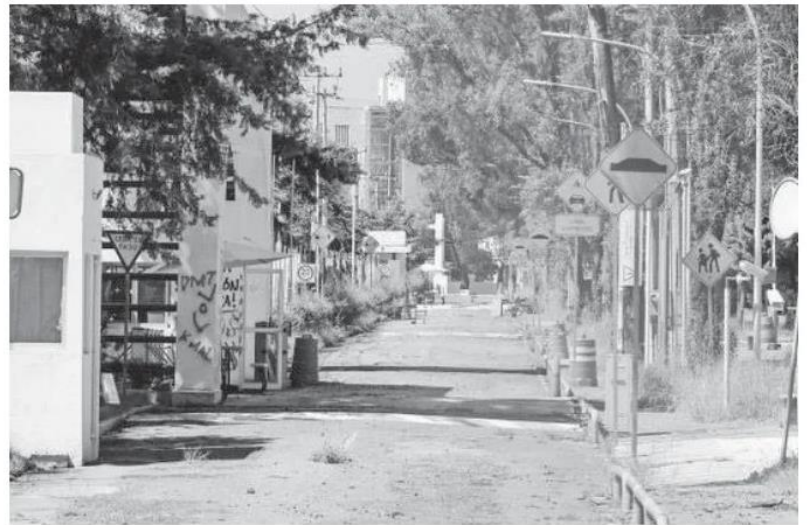
En varios espacios académicos es evidente la falta de mantenimiento
