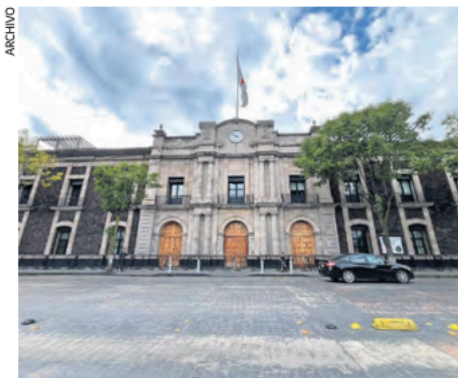
Fachada del Poder Judicial del Estado de México.
