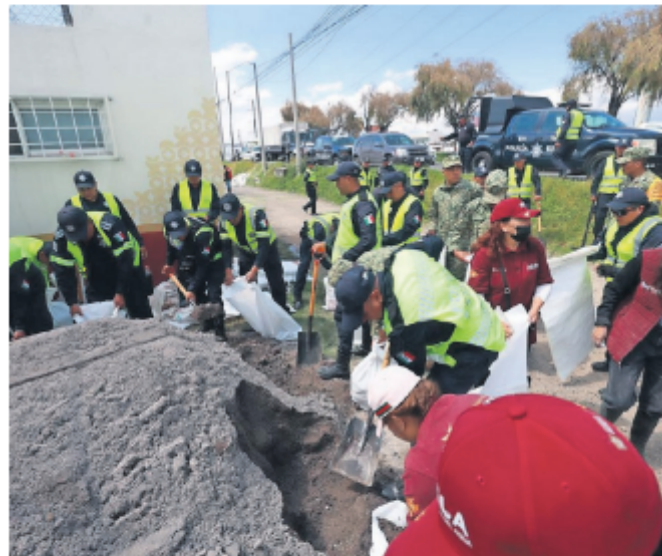
Colocaron costales de arena en las zonas más afectadas.
