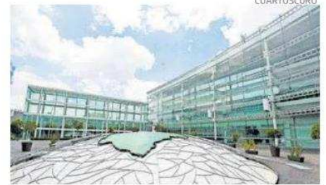
Este jueves inicia la captación de apoyos
